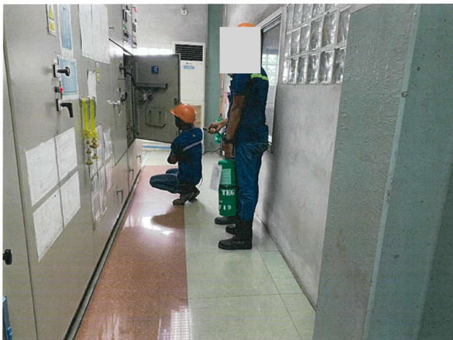
พนักงานไฟฟ้าเข้าระงับเบื้องต้น โดยสวมถุงมือป้องกันไฟดูด ก่อนเปิดตู้ 52-T2 (6.6 KV 2000V BUSTIE PANEL) เพื่อใช้ถังดับเพลิงชนิดดับไฟ
